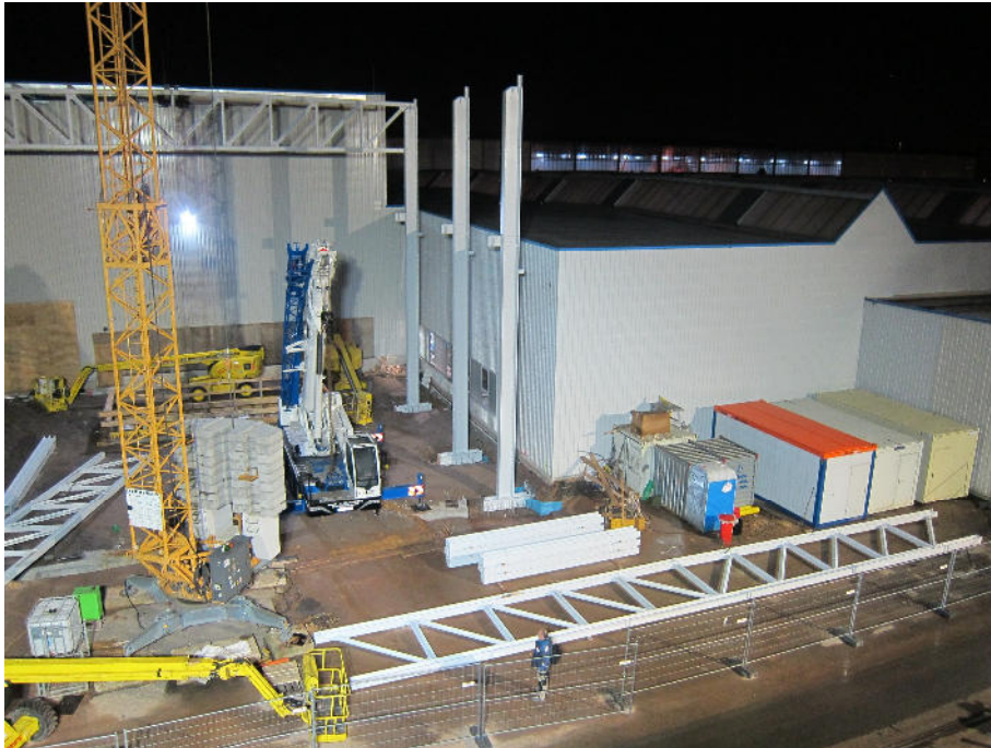
Baustellenbeleuchtung 1x 500W LED Strahler, Lichtpunkthöhe 28m Entfernung 50m Vorher 1x Industriestrahler 2500W
